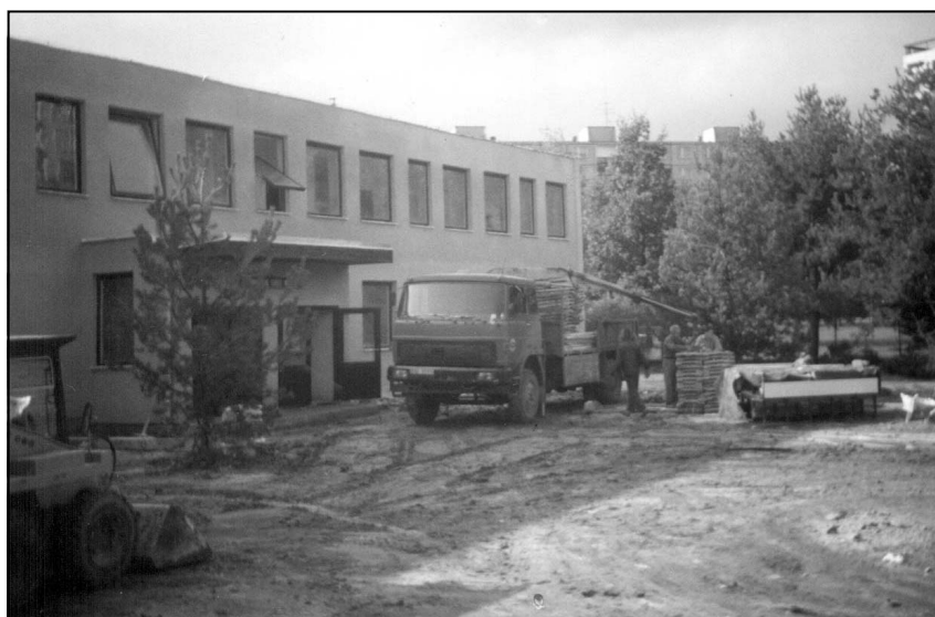
Úprava budovy gymnázia, ktoré spočiatku sídlilo na Ul. Matice Slovenskej. Vo vnútri v tom čase naplno prebiehal vyučovací proces.
